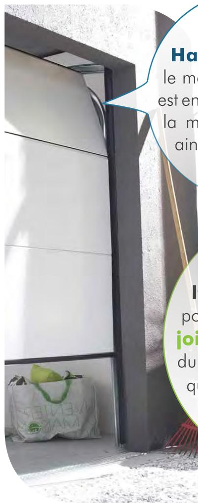
**Habituellement**, le montant de la porte est en contact direct avec la maçonnerie, créant ainsi un **pont thermique**
